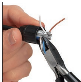
余分な電線の切断
